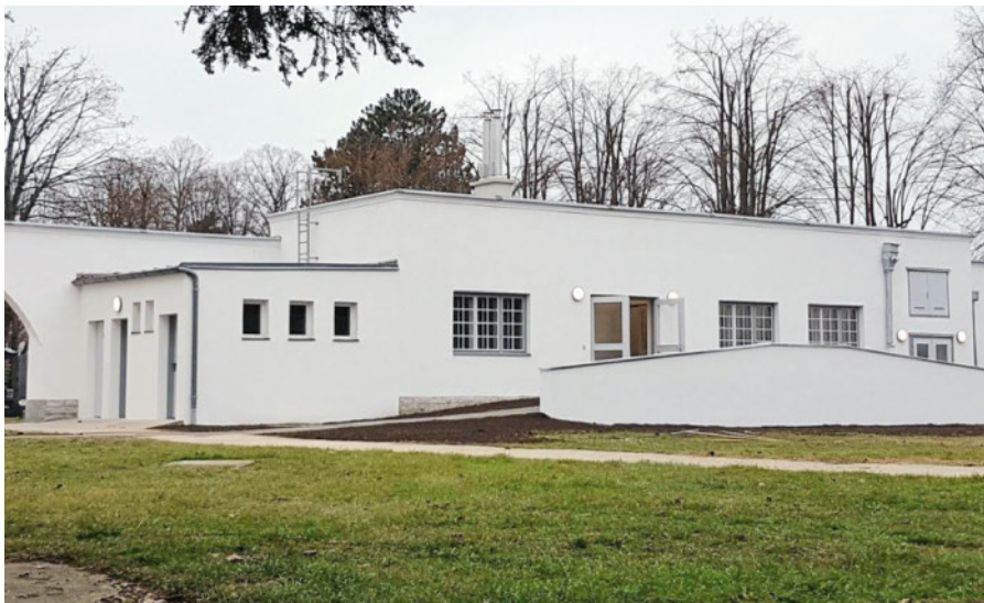
Im Taharahaushaus am Zentralfriedhof, Tor 4, werden die rituellen Waschungen vor dem jüdischen Begräbnis durchgeführt.
